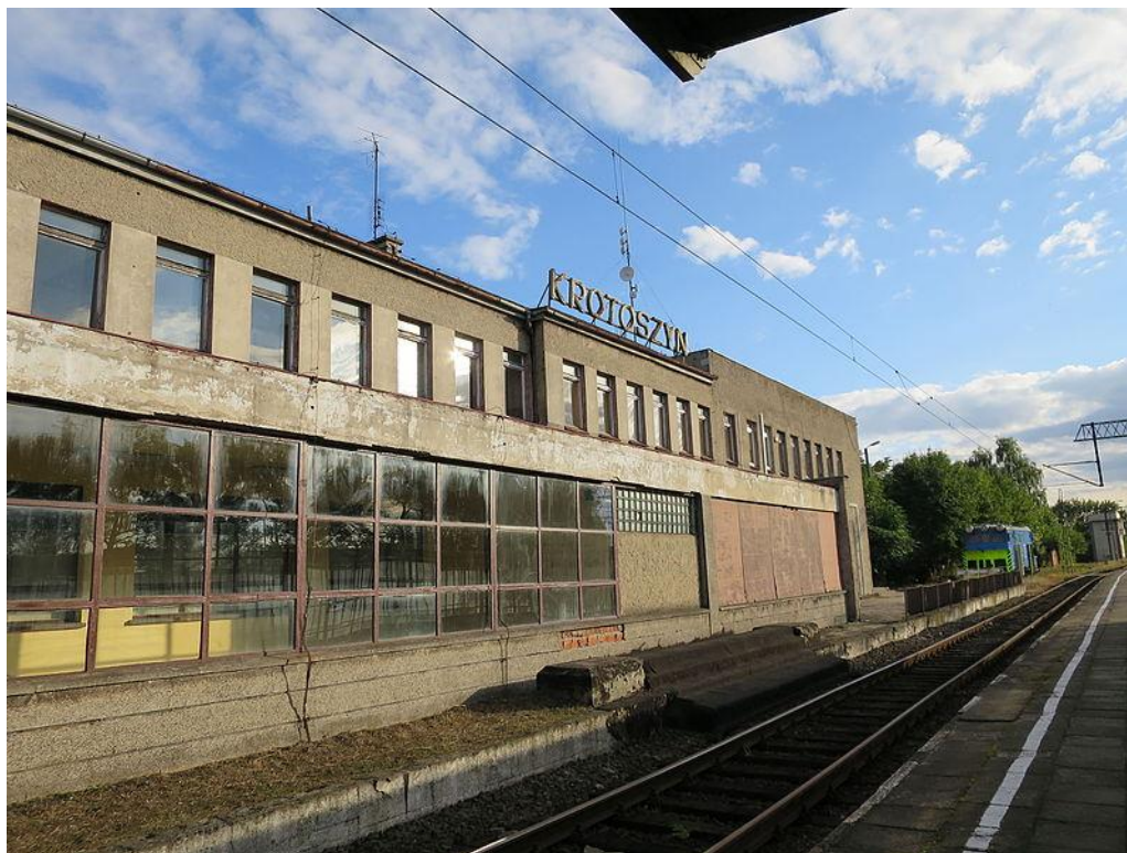
Fotografia 5. Stacja kolejowa w Krotoszynie, fot.1
