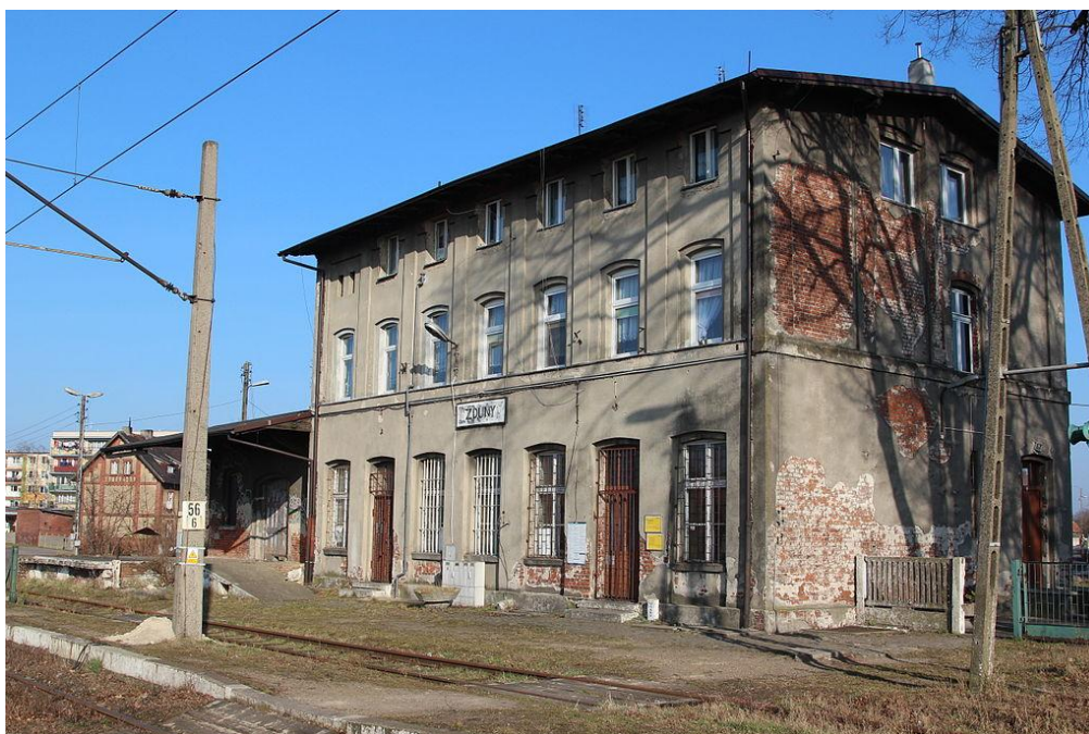
Fotografia 7 Stacja kolejowa w Zdunach
